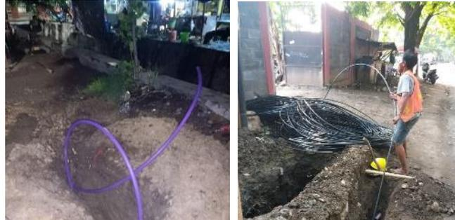
*Gambar 4. Pengawasan instalasi Subduct dan Kabel Fiber Optic*
