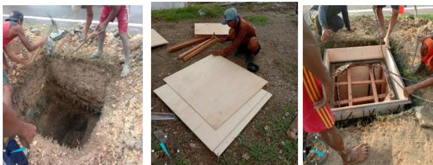
*Gambar 5. Pengawasan pekerjaan pembangunan Handhole*
