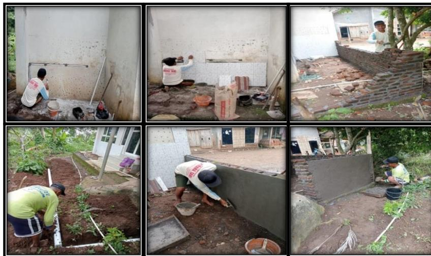
Gambar 4. Tahapan Proses Pembuatan Tempat Wudhu
