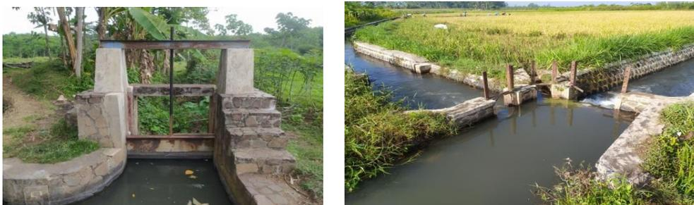
Gambar 3. Kondisi pintu intake dan bangunan pembagi
