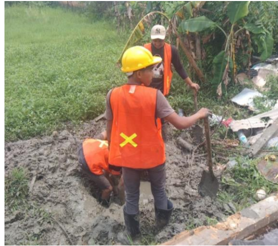
Gambar 2. Kondisi tanah setelah pembersihan Sumber: Dokumentasi pribadi
