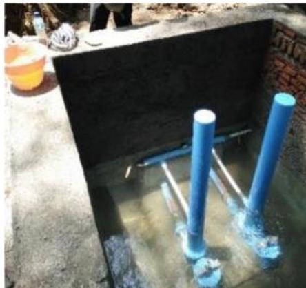
Gambar 2 Pompa hidram (Asmaranto et al, 2017)
