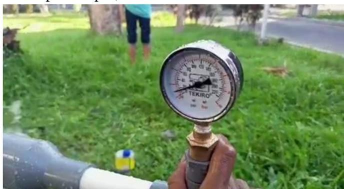
Gambar 8 Pemasangan *pressure gauge* pada keluaran pompa
