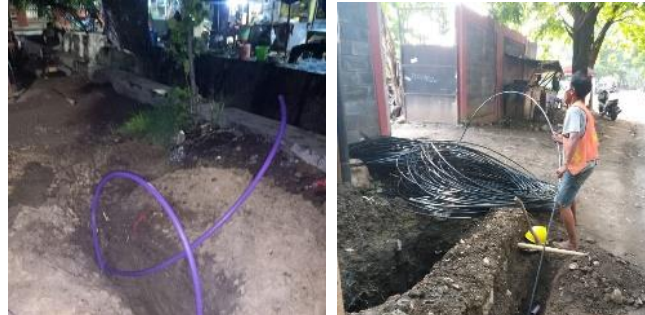
Gambar 4. Pengawasan instalasi Subduct dan Kabel Fiber Optic
