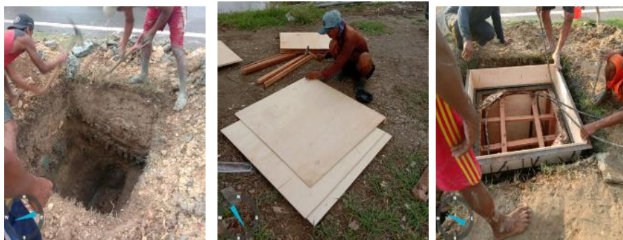
Gambar 5. Pengawasan pekerjaan pembangunan Handhole
