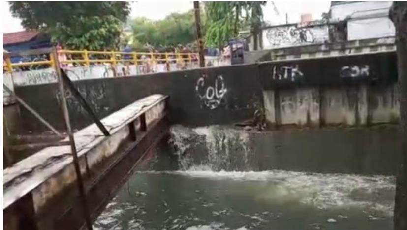
Gambar 2. Tanggul Kali Sekertaris Yang Bocor (Suara.com, 2020)
