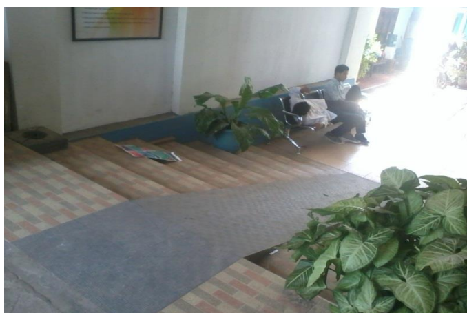
Gambar 6. Aksesibilitas jalan di SDN 01 Wirolegi Kabupaten Jember
