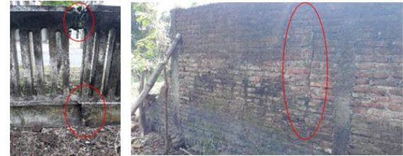
Gambar 1 Foto Kerusakan Bangunan Akibat Tanah Ekspansif di Tempat Studi Pustaka yang ditinjau
