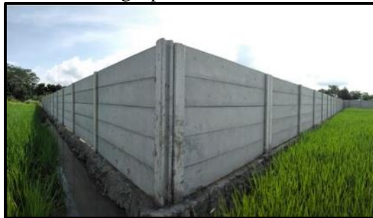
Gambar 1 Pagar Panel Beton dilapangan Sumber : Dokumentasi, 2024
