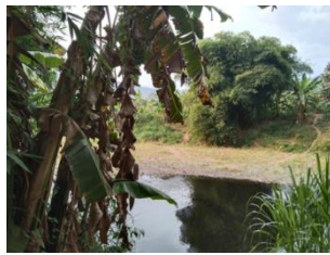
Gambar 13. Kondisi Lapangan Pada River Sta. 14
