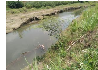
Gambar 19. Kondisi Lapangan Pada River Sta. 3
