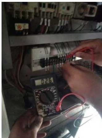
Gambar 6. Pengecekan konektivitas grounding
