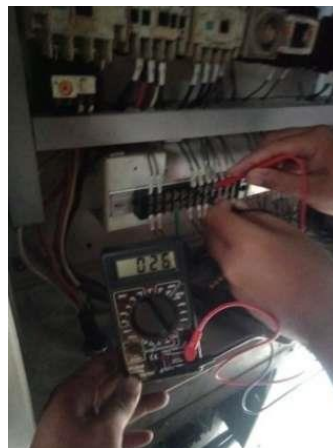
Gambar 6. Pengecekan konektivitas grounding
